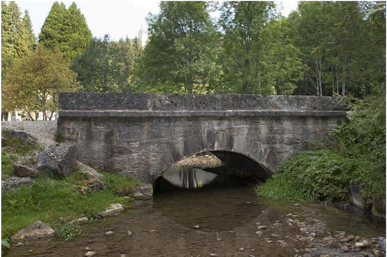
Pont sur la Jougne (n° 4), vu depuis l'aval.
