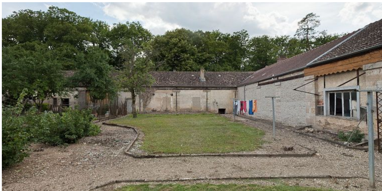
Vue de la cour intérieure.
