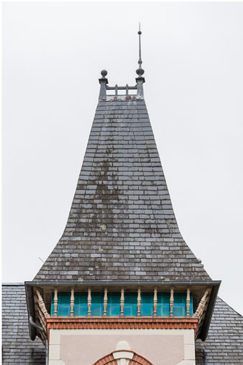
Tour demi-hors-œuvre, toiture et crête faîtière.
