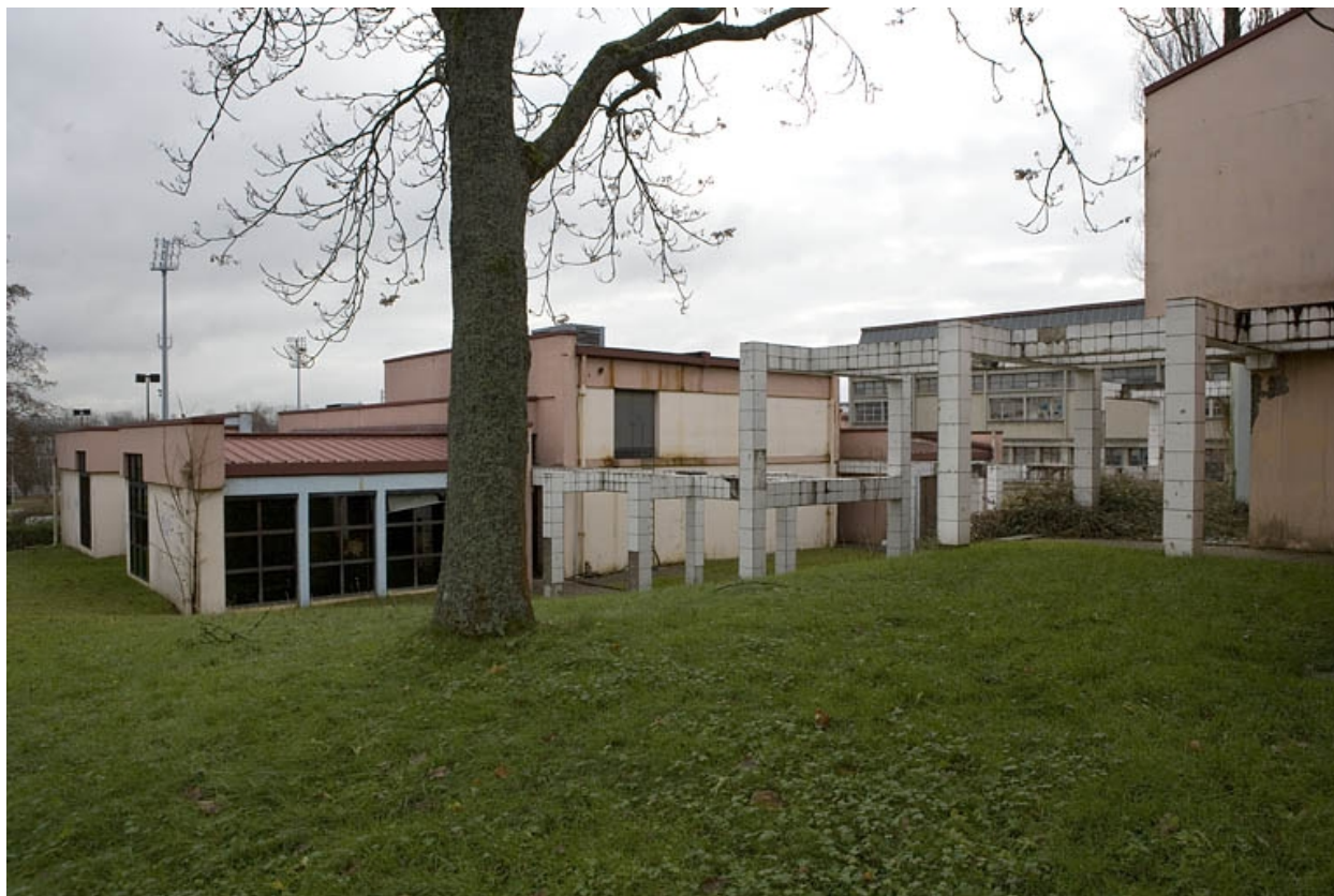
Vue de trois quarts gauche bâtiment J.
