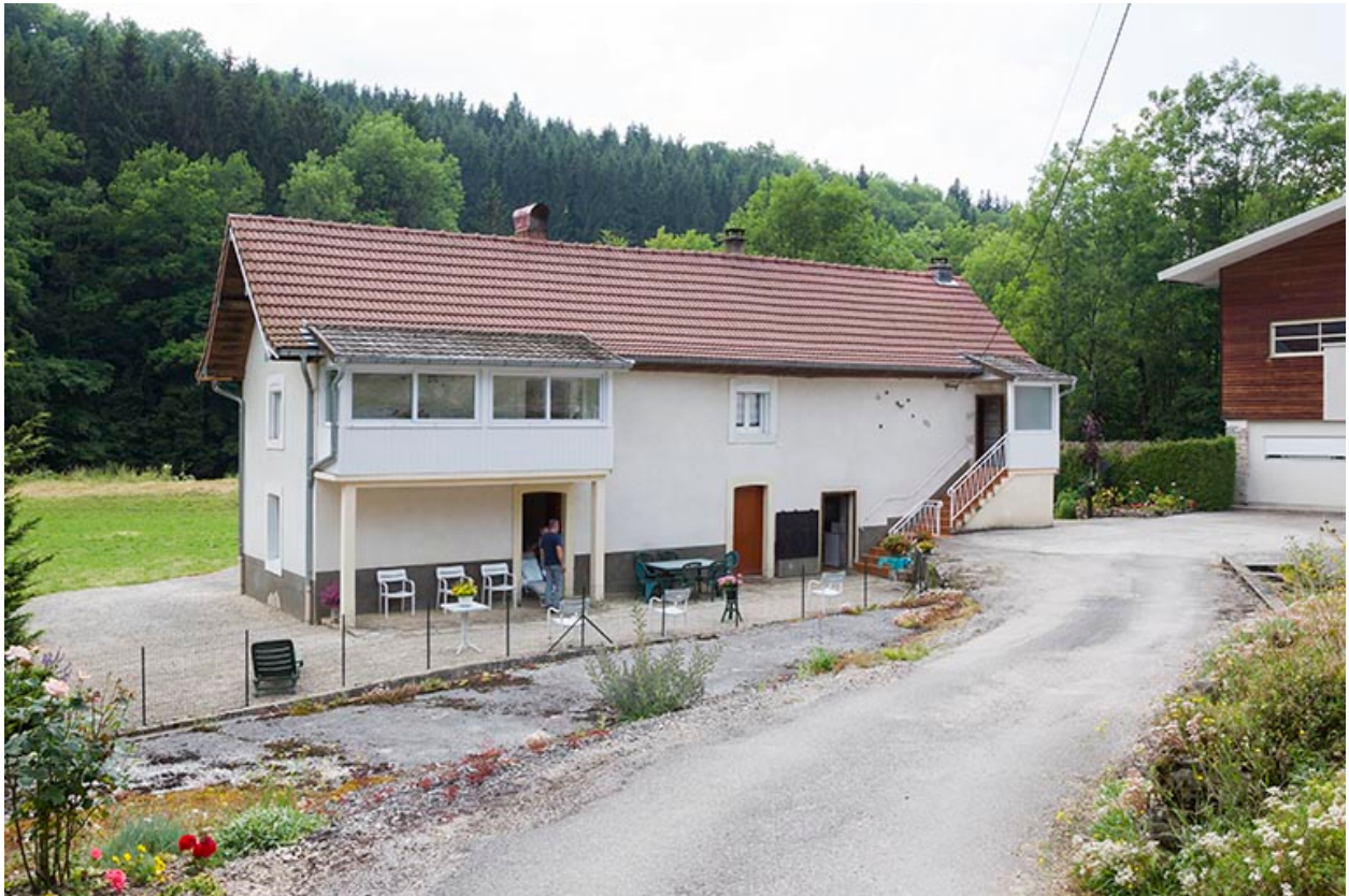
Site de la scierie : logement d'ouvriers.
