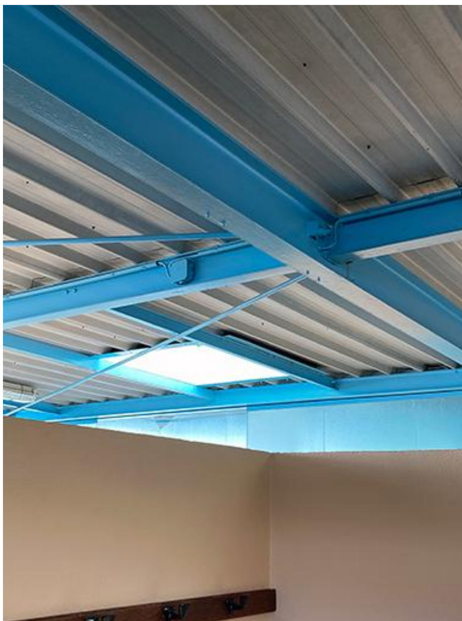
Les poutres métalliques dans les vestiaires.
