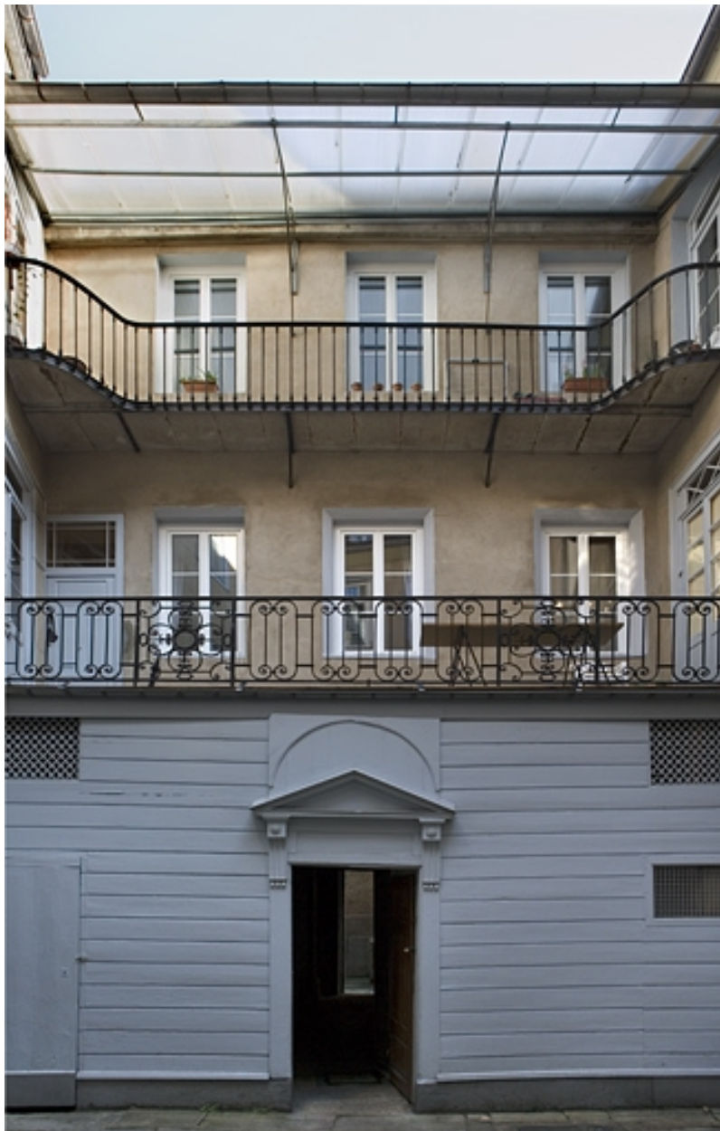
Première cour : détail de la façade principale du logis secondaire.
