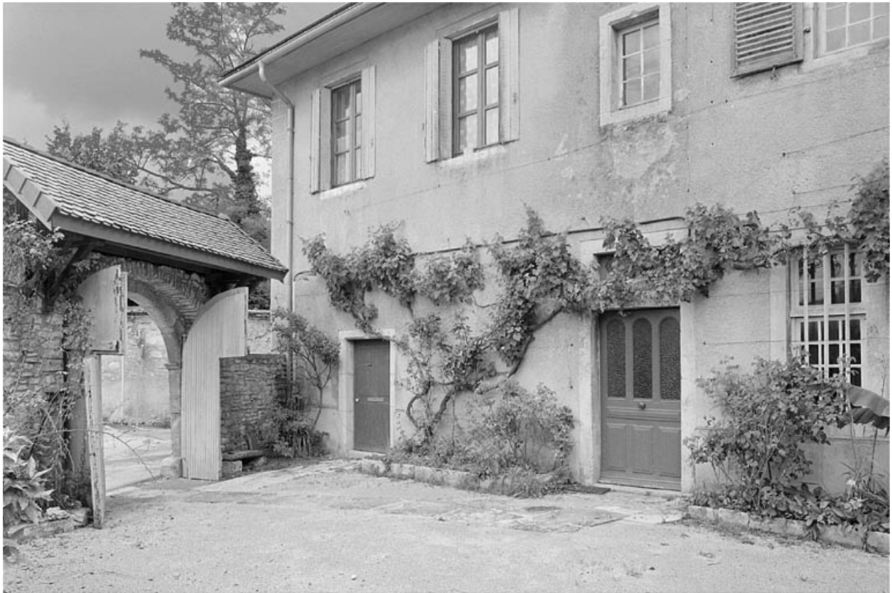
Façade antérieure, partie gauche.
