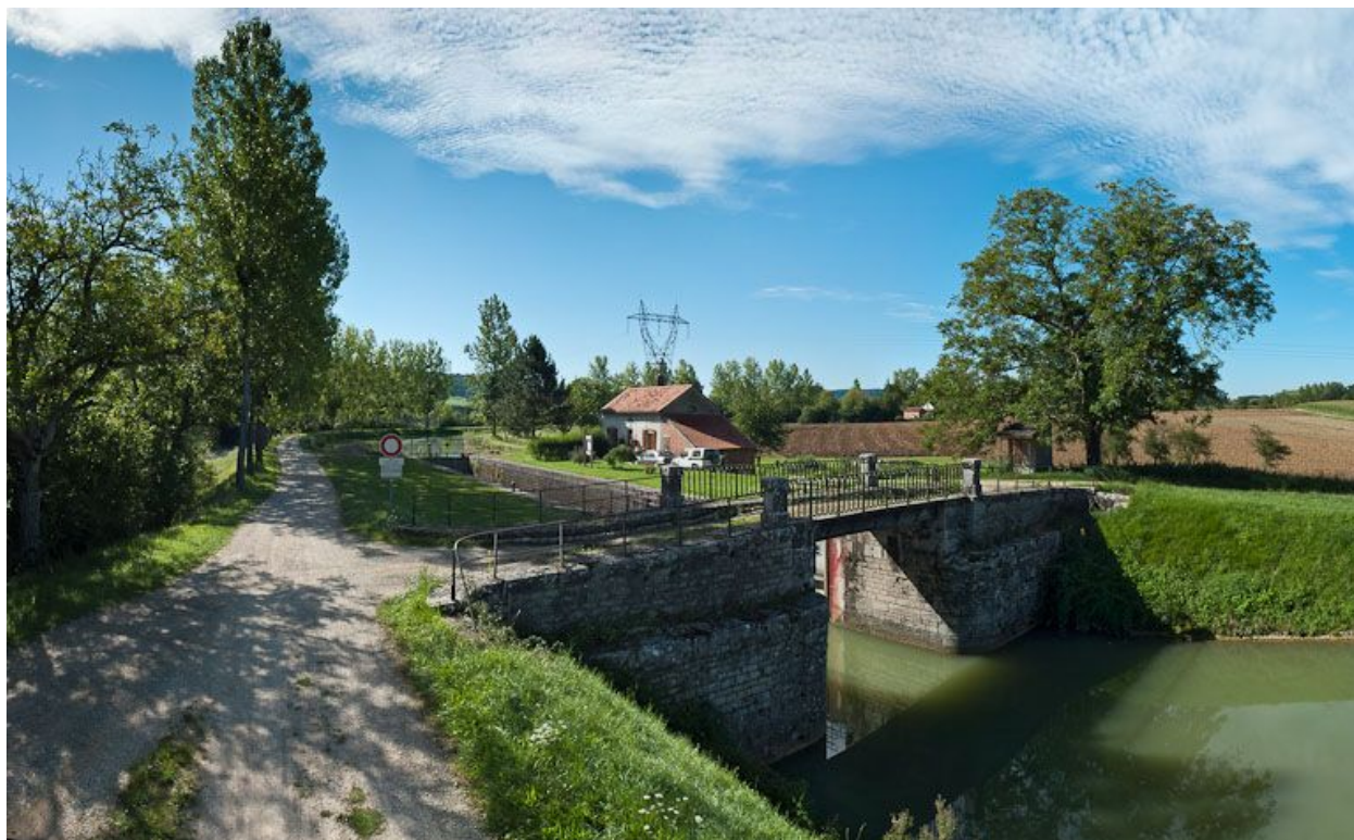
Vue d'ensemble du site d'écluse.
