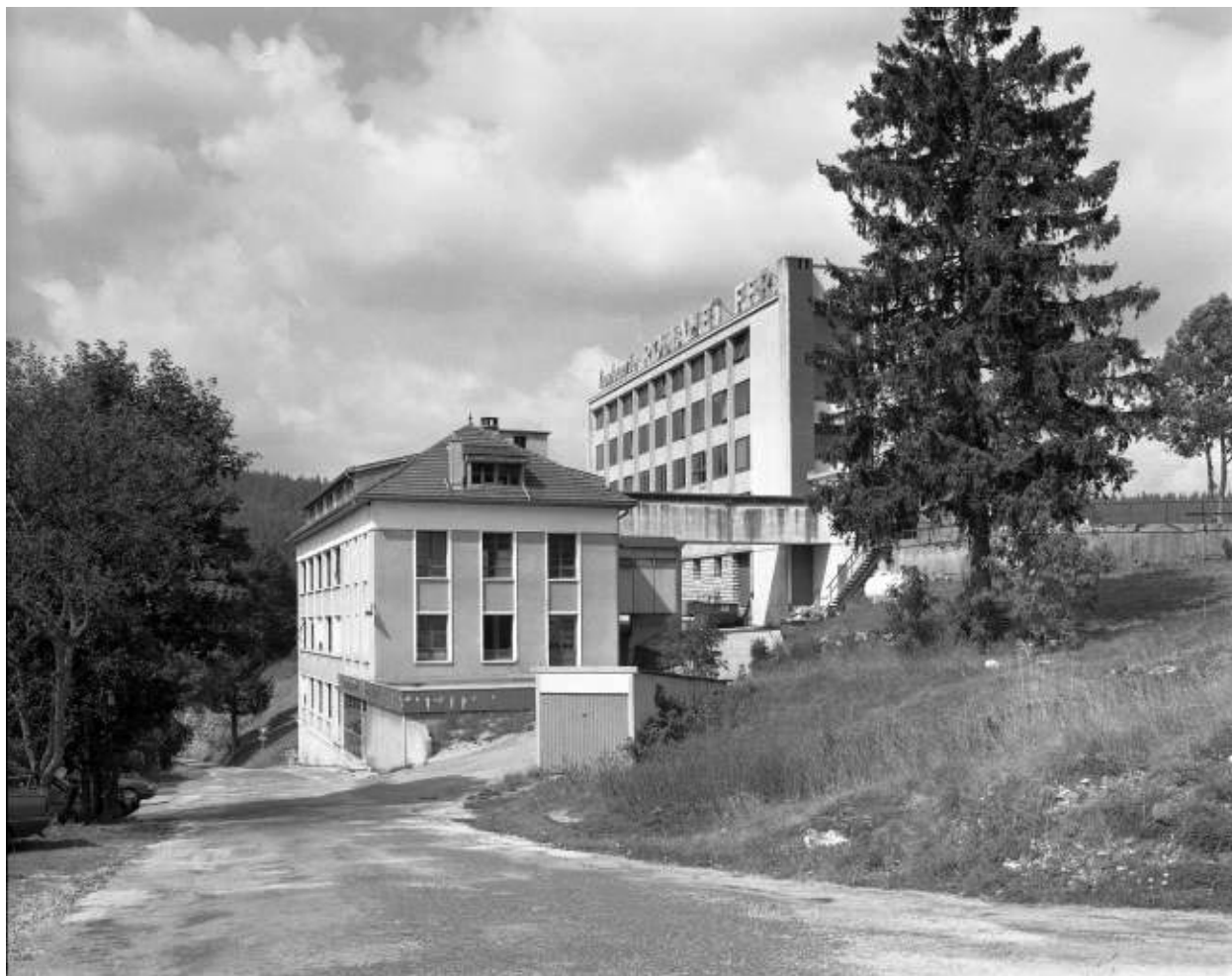
Façade latérale droite des bâtiments.
