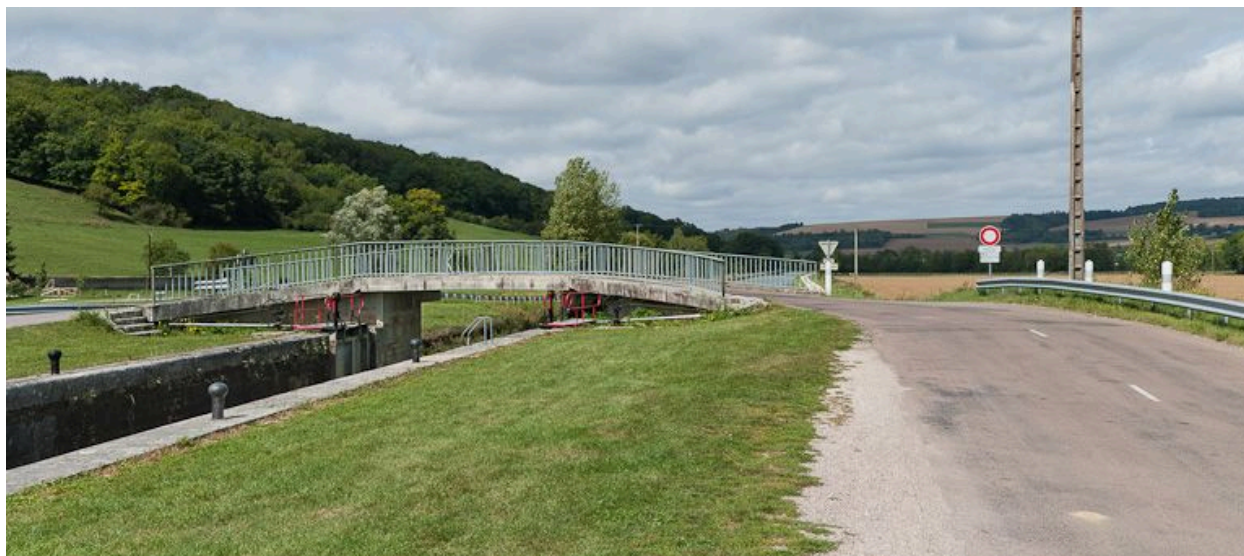
Vue du pont depuis l'amont.
