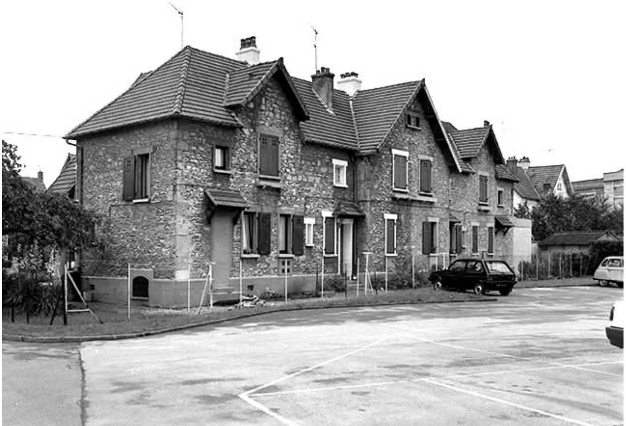
Façade postérieure de l'immeuble de type 1, 10, 12, 14, 16 rue du Bougney.
