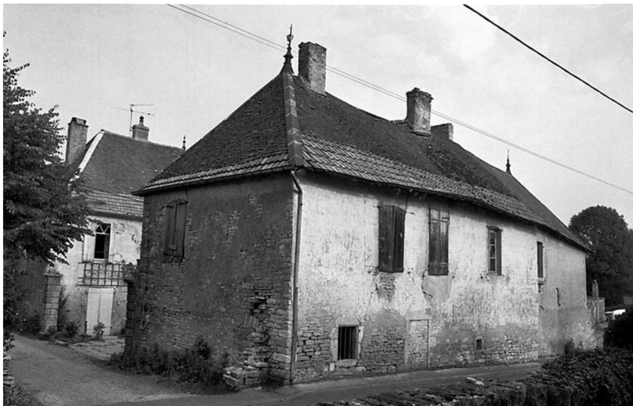
Façade sur rue de l'habitation droite.
