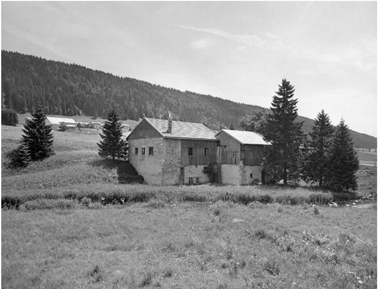
Scierie (actuellement maison) située au lieudit La Scie Neuve.
