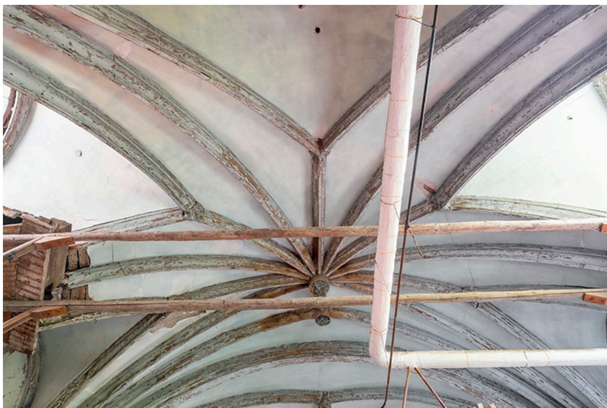
Voûtement du chevet de la chapelle (et pièces de charpente de consolidation).
