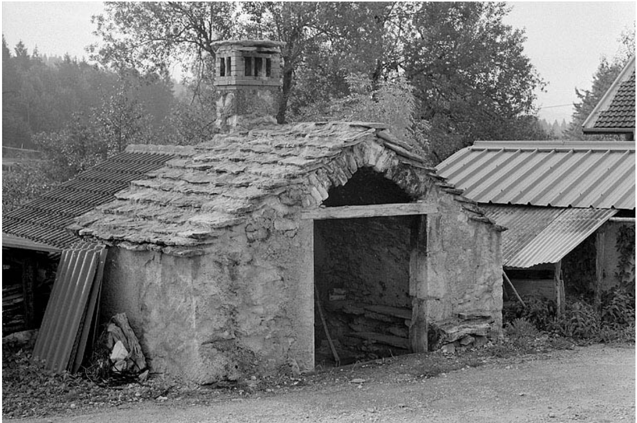
Fornil situé au lieu-dit Sièges.
