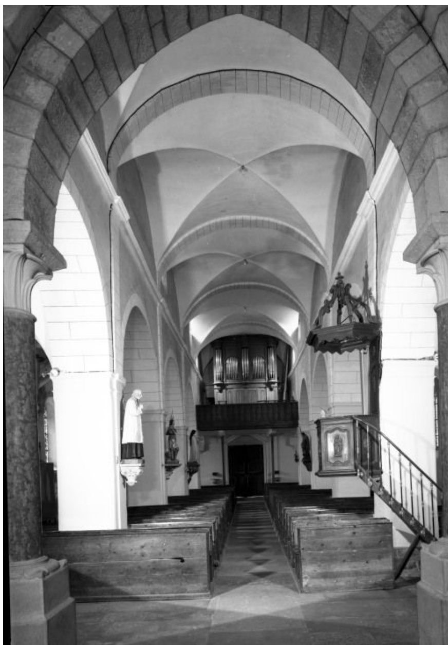
Vue intérieure prise du chœur
