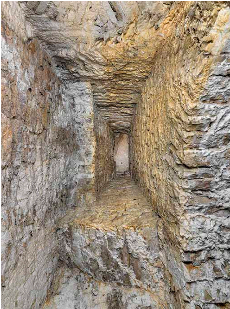
Hotte d'une cheminée.
