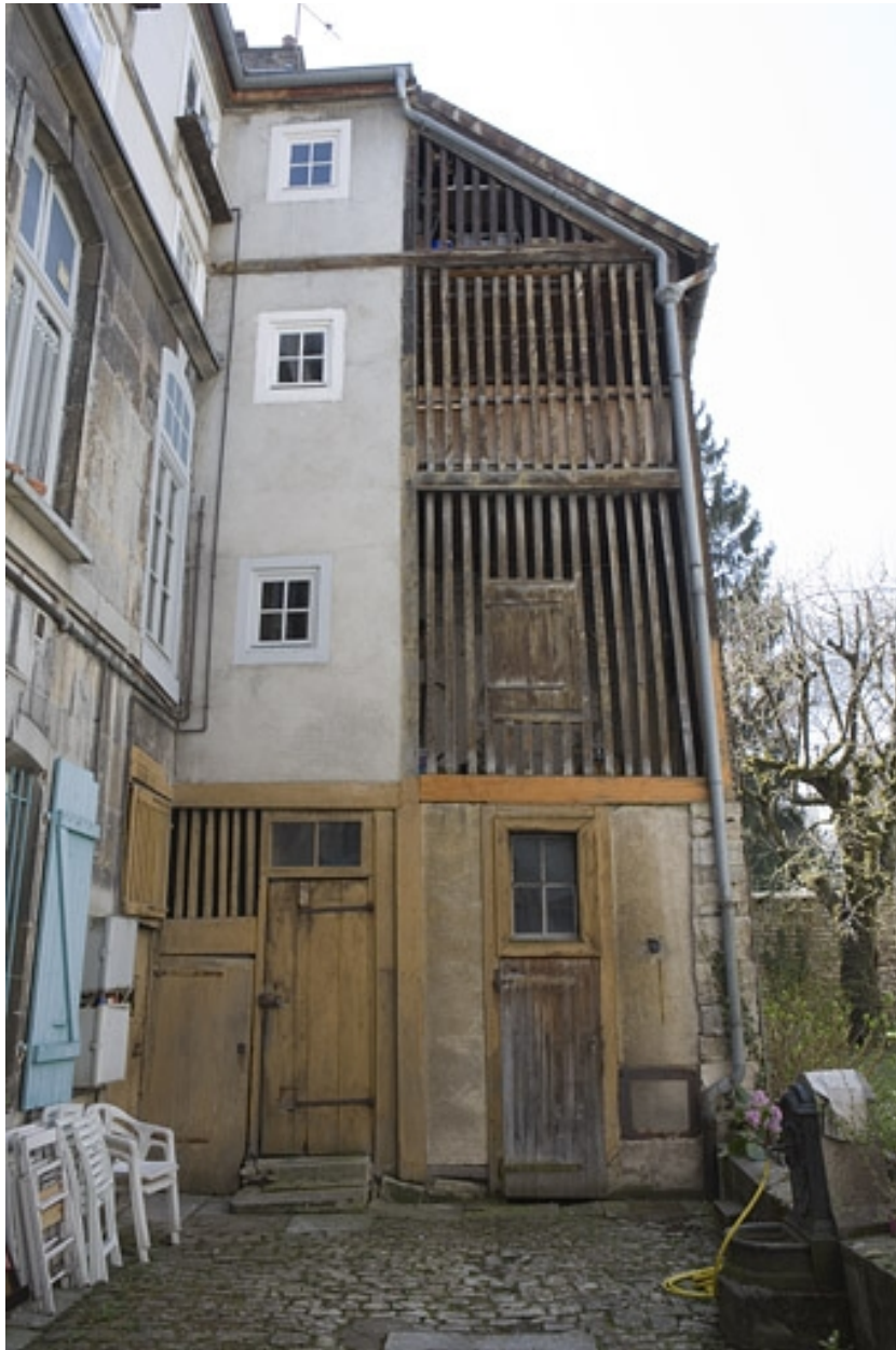
Détail de l'aile des bûchers sur jardin.
