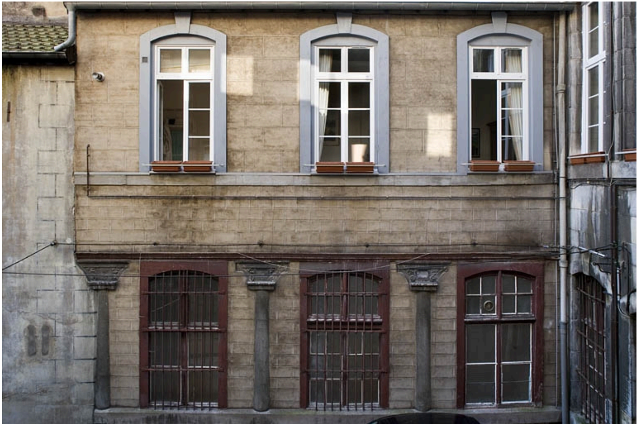
Vue d'ensemble du portique à droite de la deuxième cour.
