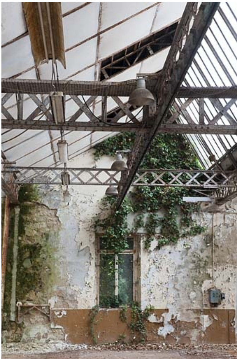
Atelier de fabrication. Travée de shed.
