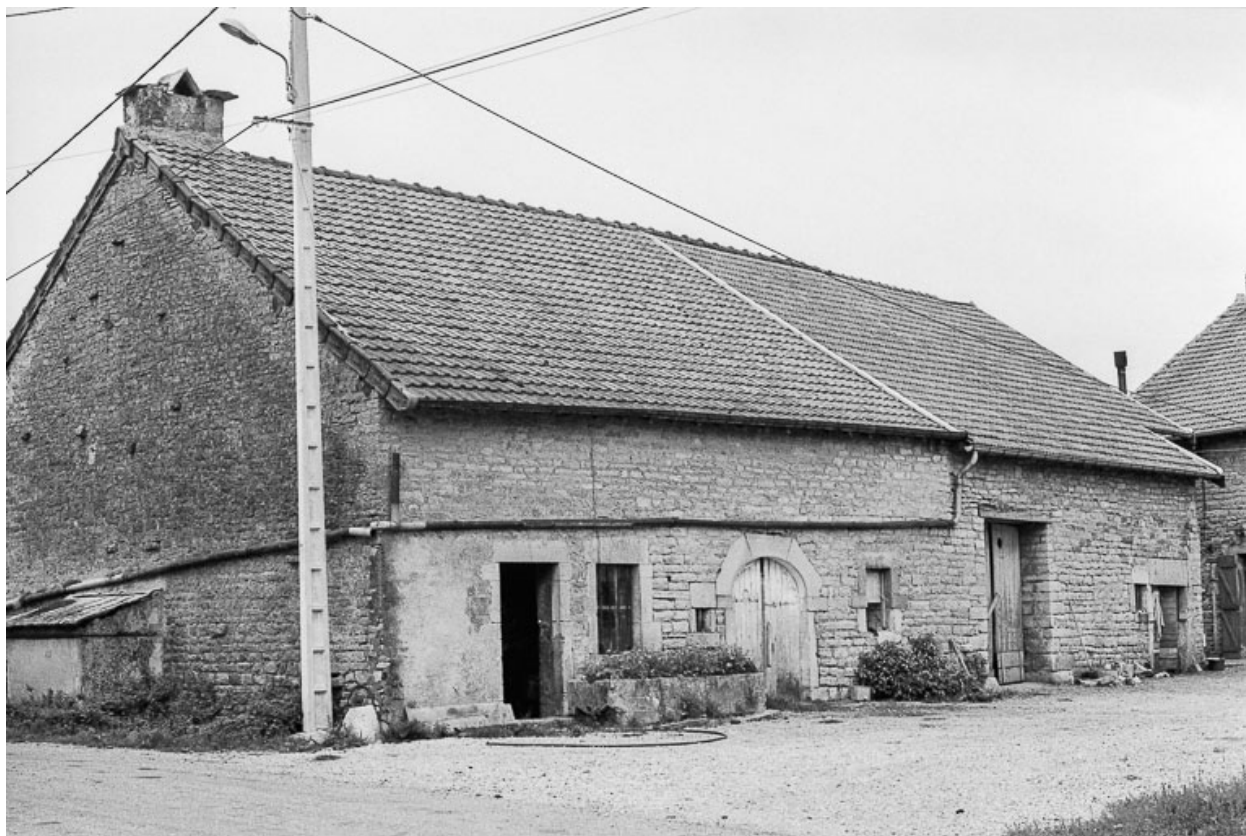
Ferme cadastrée B2 157 : façade sur rue.
