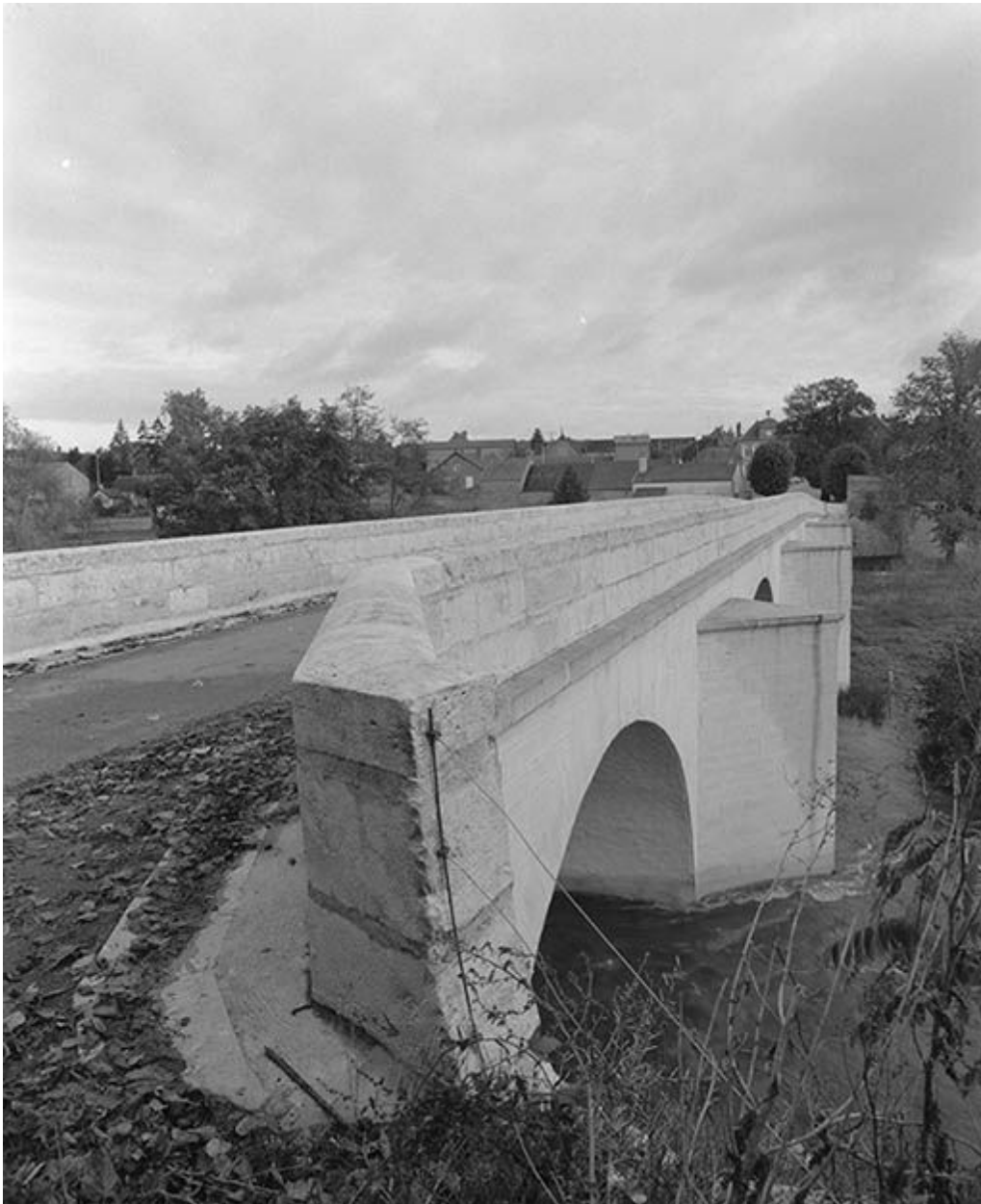
Vue prise de l'amont, côté village.
