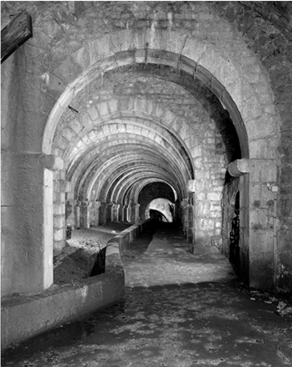
Galerie de communication entre les puis d'Amont et d'Aval (1993).
