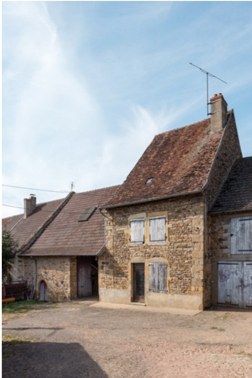
Vue de la ferme n°4 (A 379).
