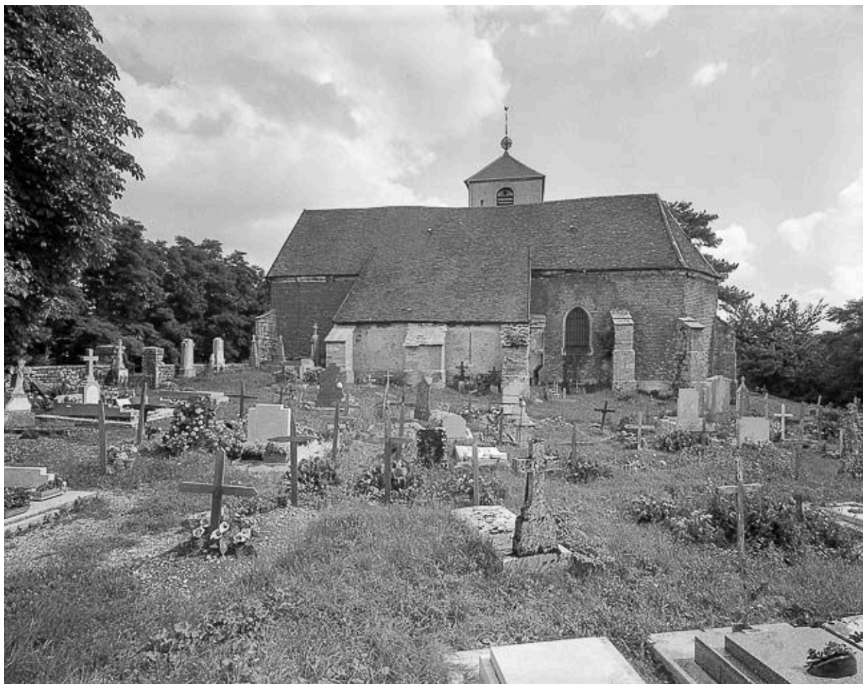
Façade latérale droite.
