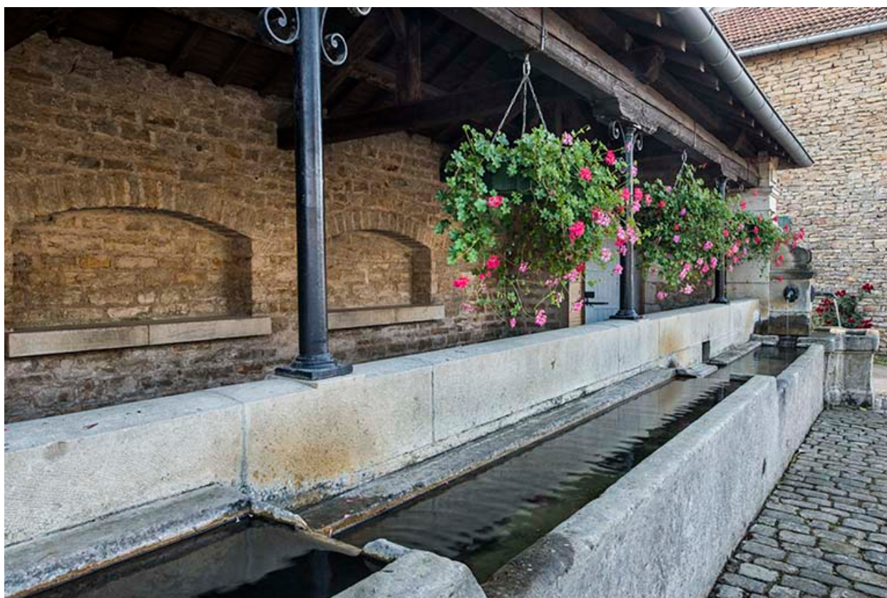
Les abreuvoirs et la colonne métallique.
