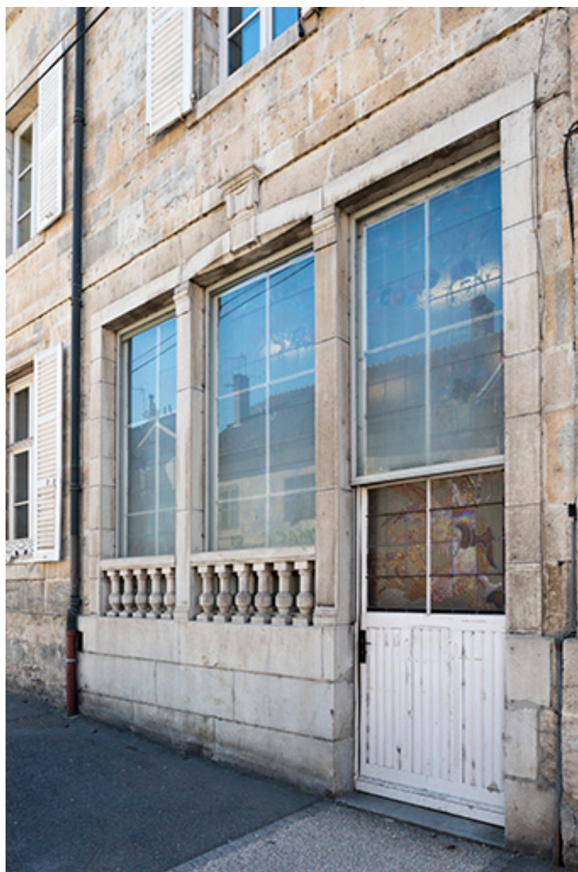
Partie occidentale de la façade antérieure.
