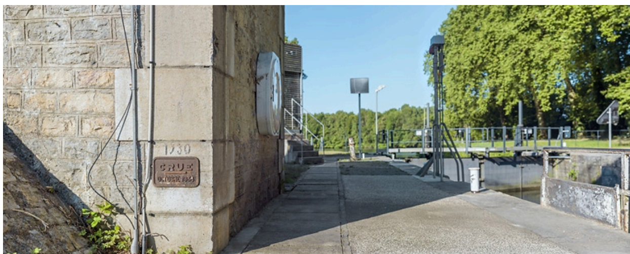
Repère de crue sur la culée du pont.
