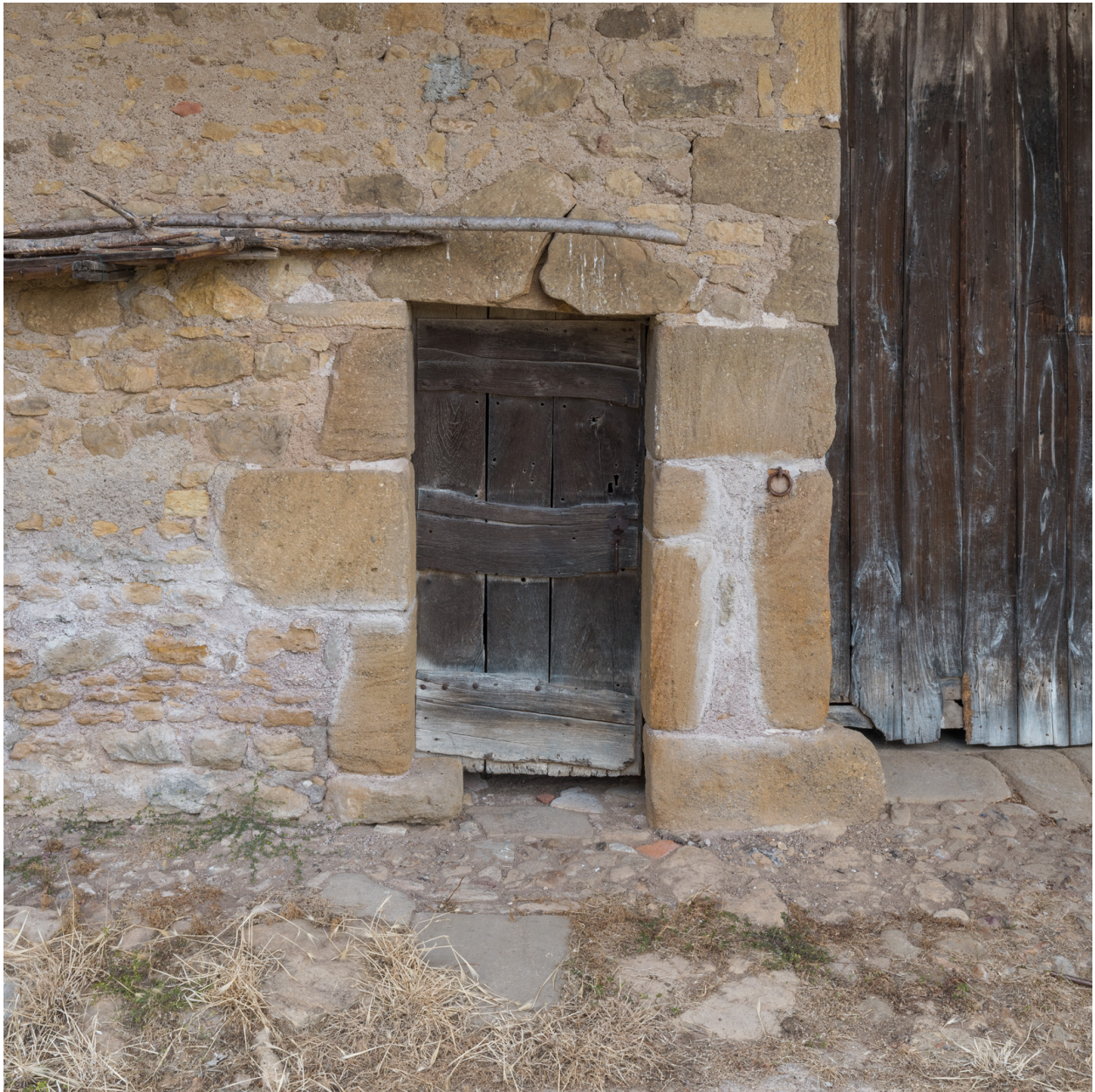
Façade antérieure du bâtiment agricole. Porte piétonne.
