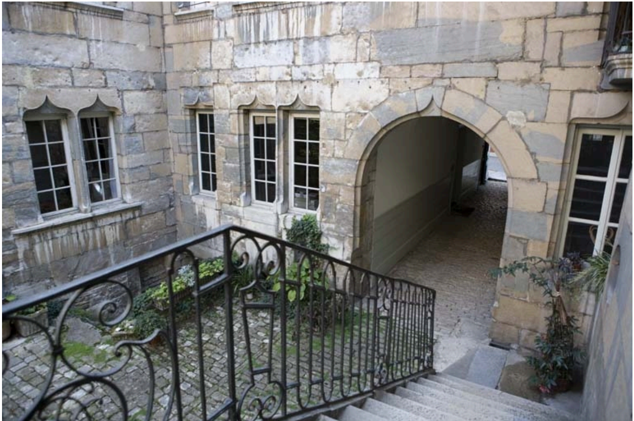
Détail du rez-de-chaussée sur cour depuis l'escalier.
