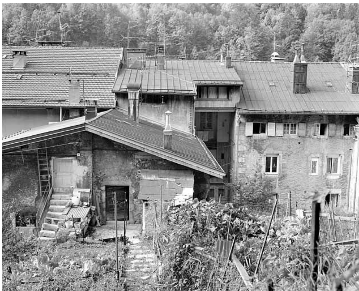
Ancien atelier : mur pignon oriental.
