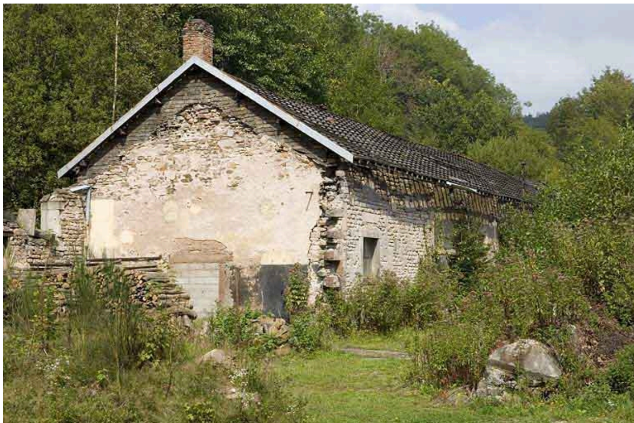
Ancien atelier de fabrication (galvanisation et trempe).
