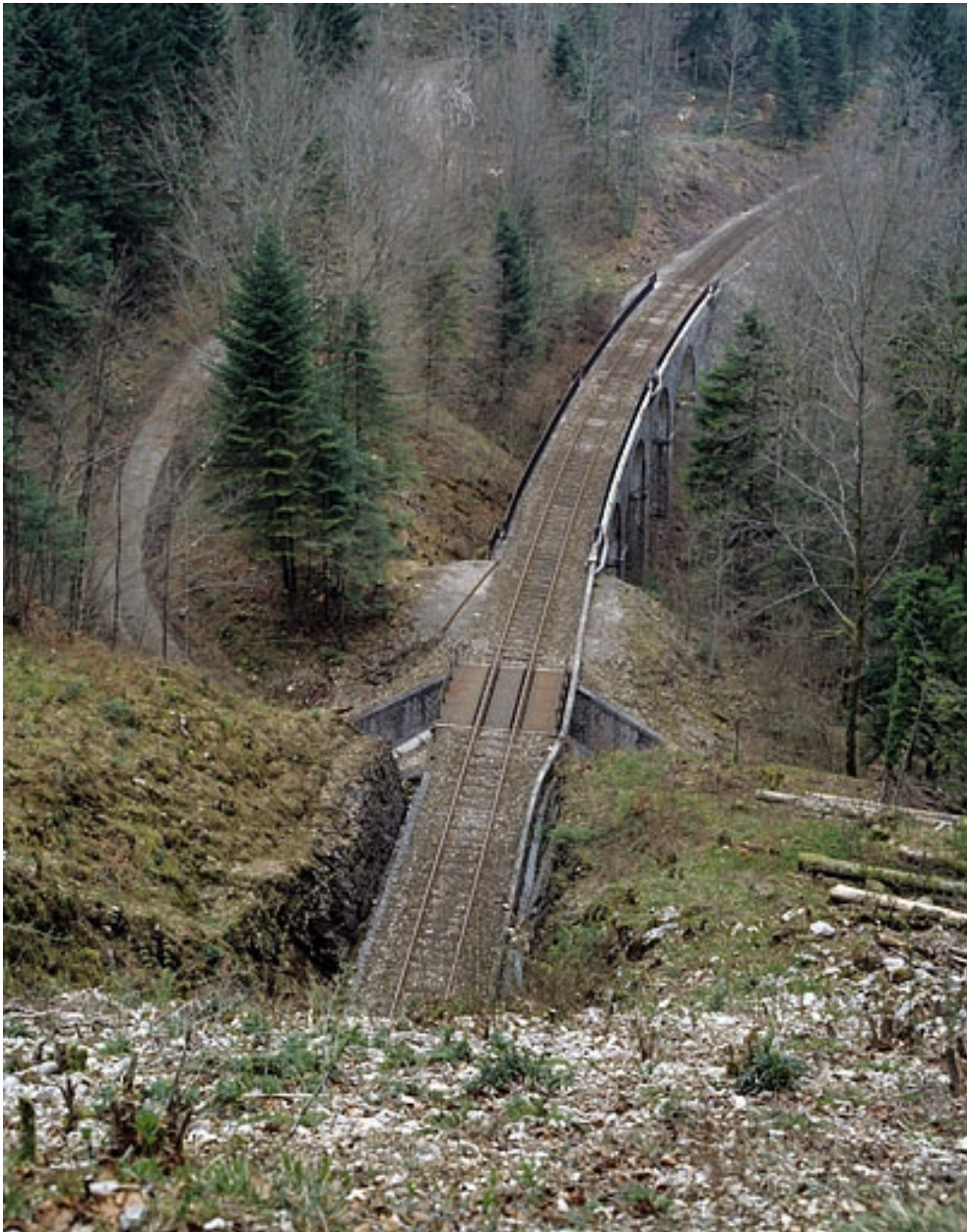
Vue d'ensemble plongeante, depuis la tête ouest du tunnel (côté Andelot-en-Montagne).
