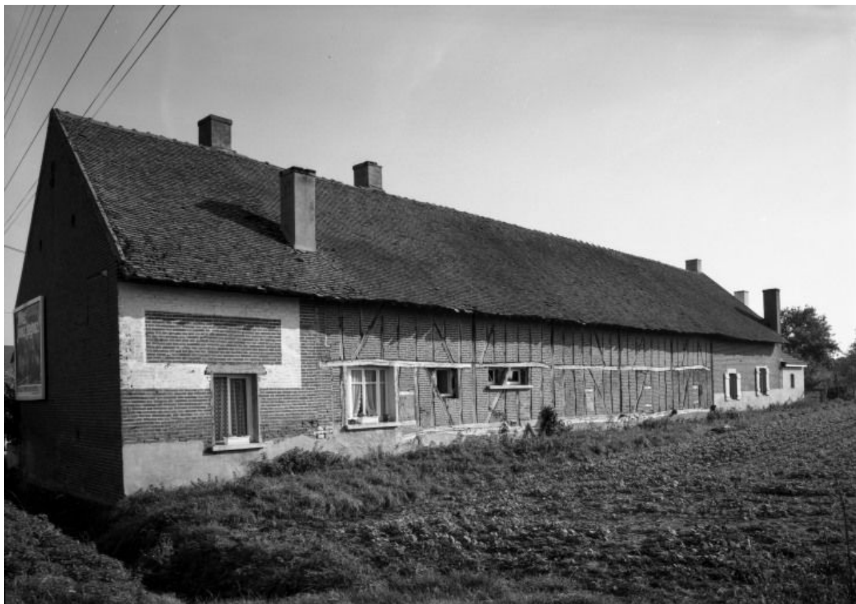
Vue d'ensemble d'une maison (cada. 1969, sect. D, parc. 124-123).
