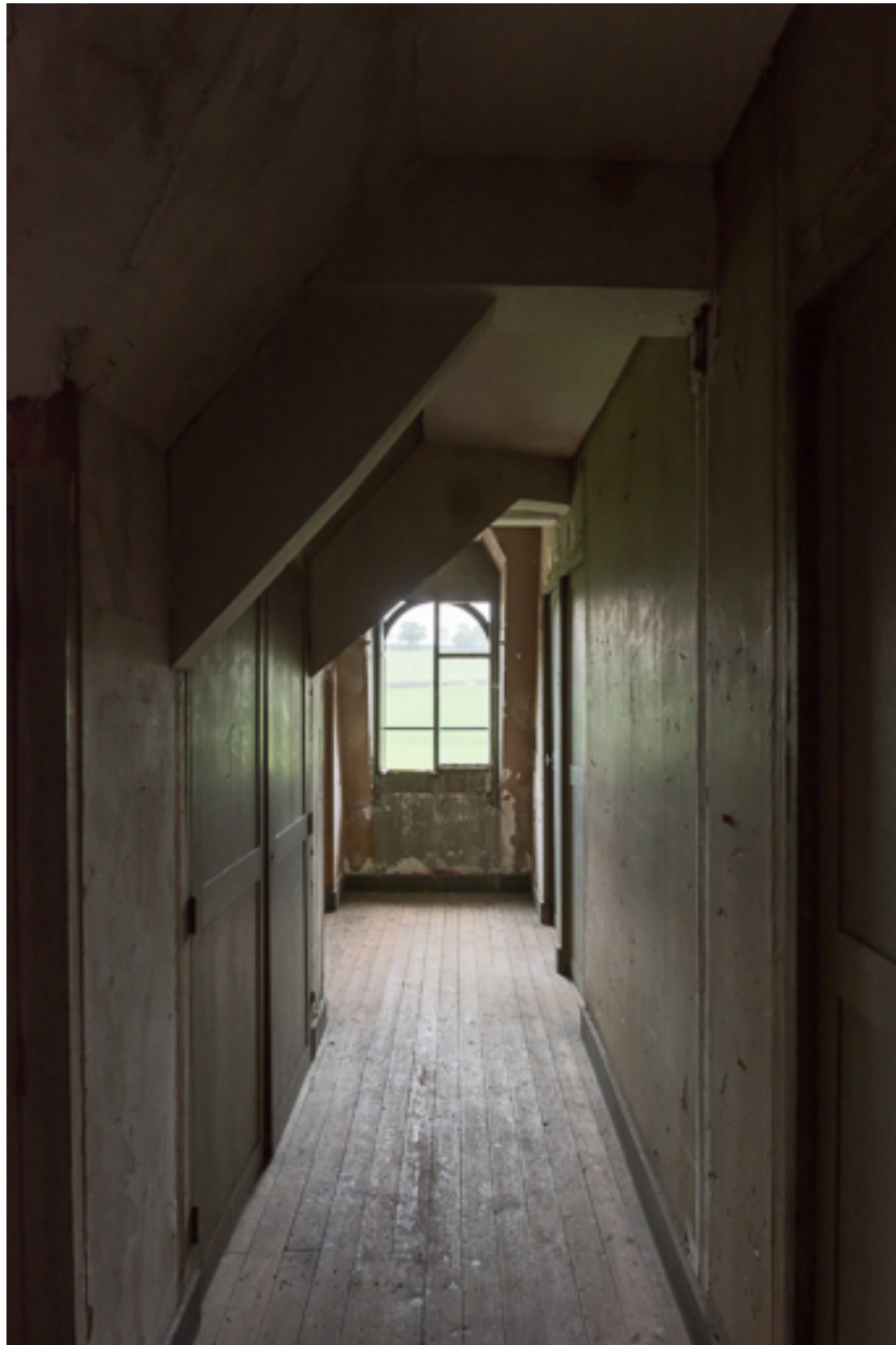
Corridor dans le comble, desservant les anciennes chambres de domestiques
