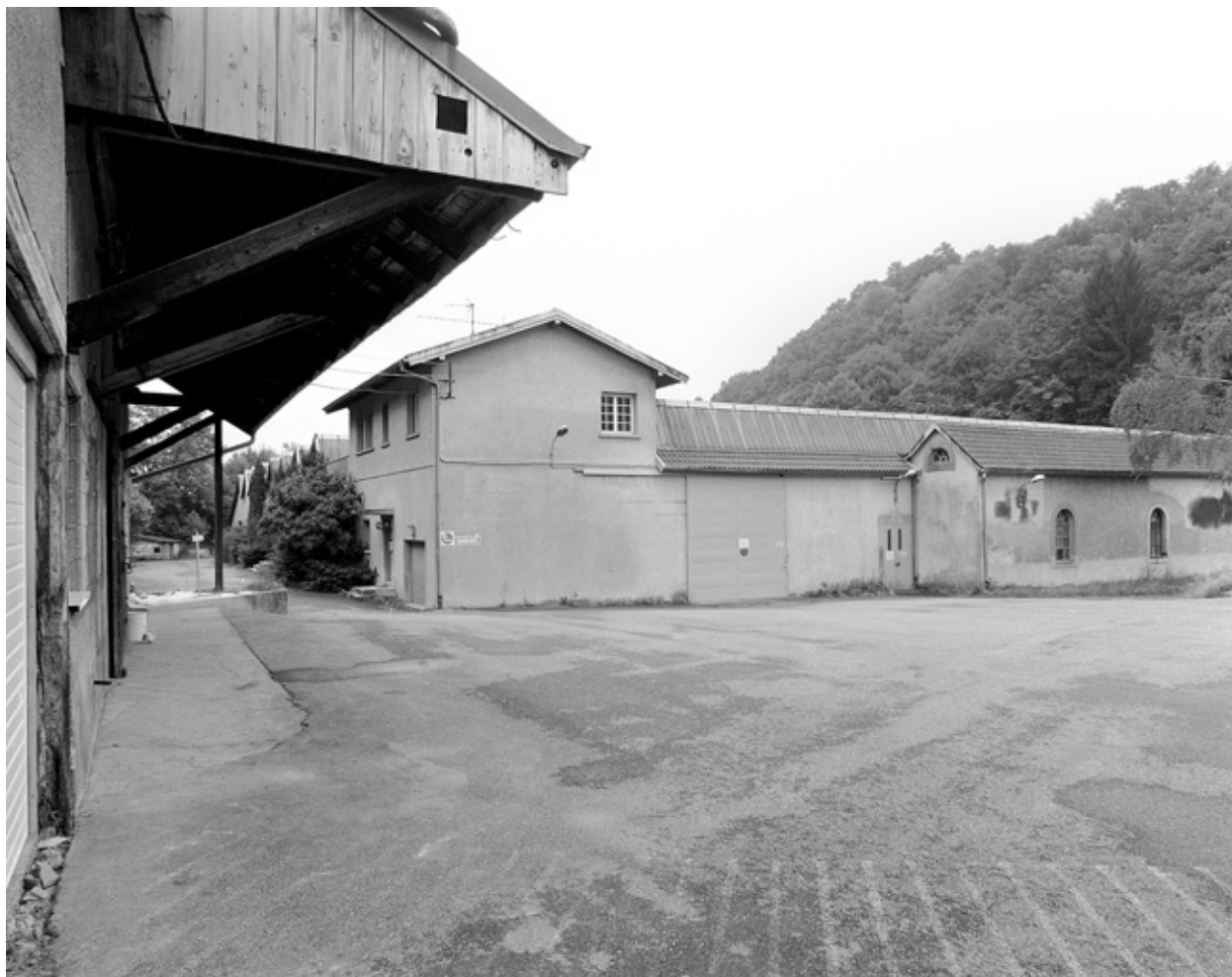
Bâtiments de la filature depuis le nord.
