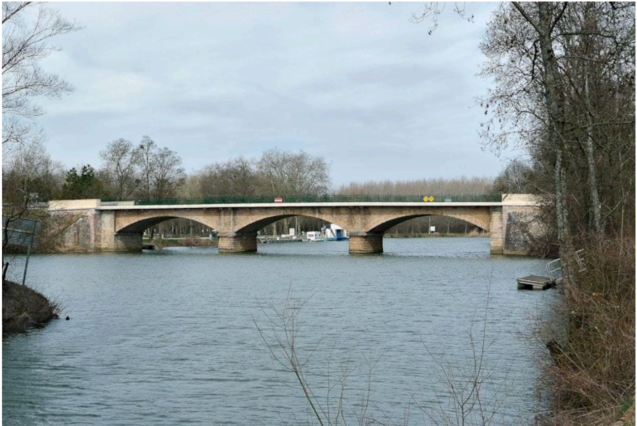
Le pont de Cuisery, vue d'amont.
