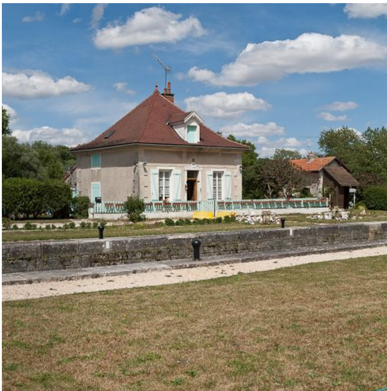
Vue de la maison éclusière.
