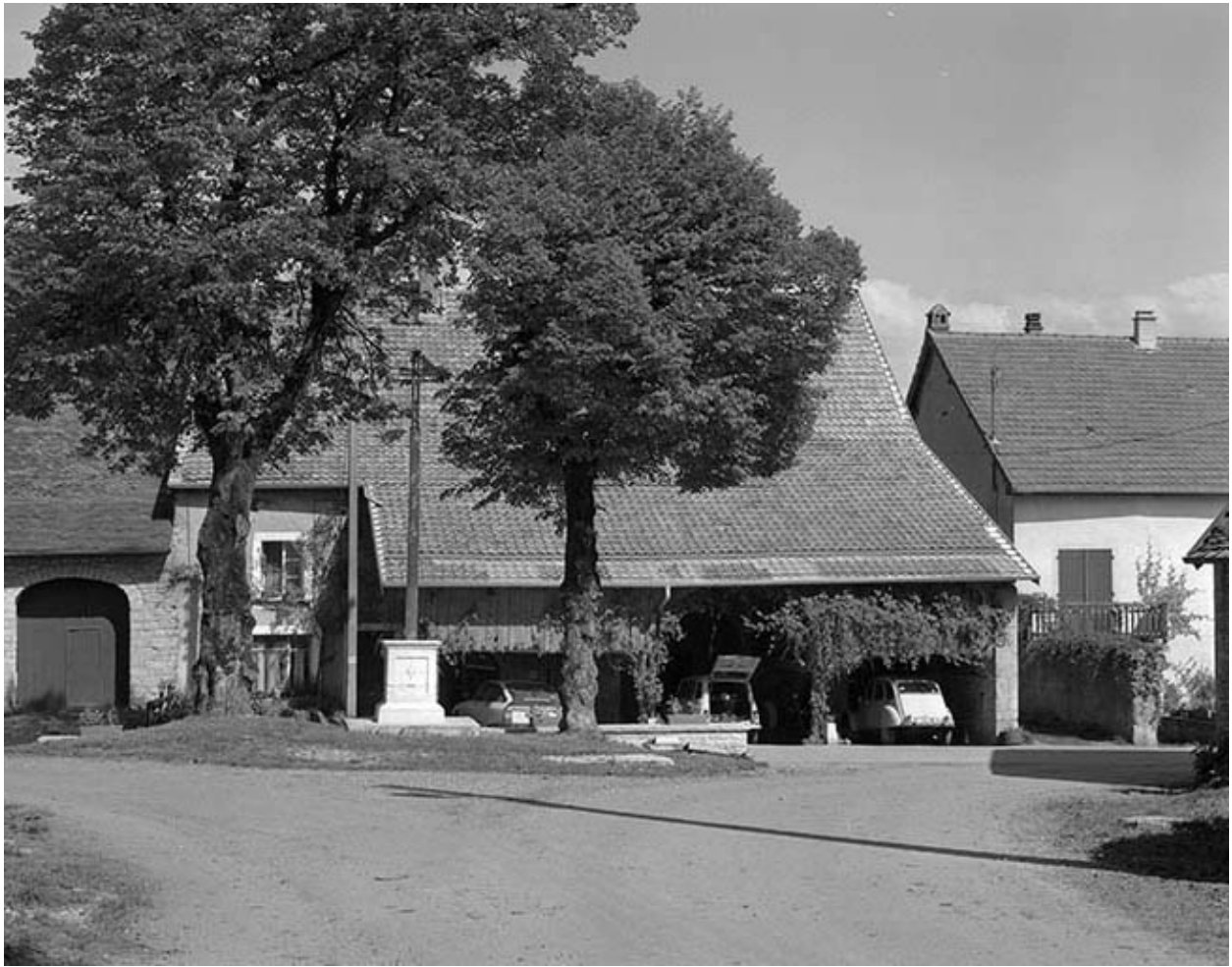
Ferme située rue du Château.
