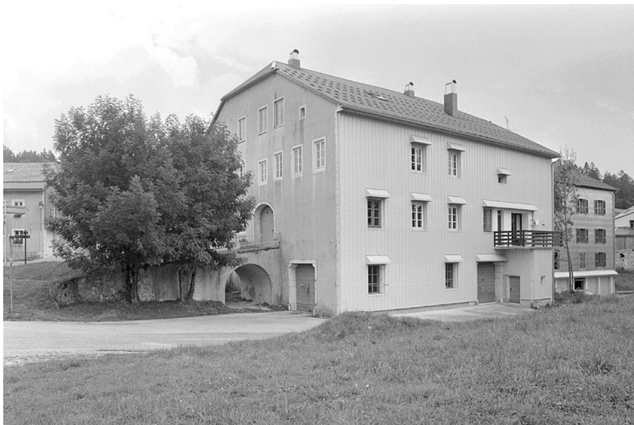
Façade postérieure et face nord-ouest.
