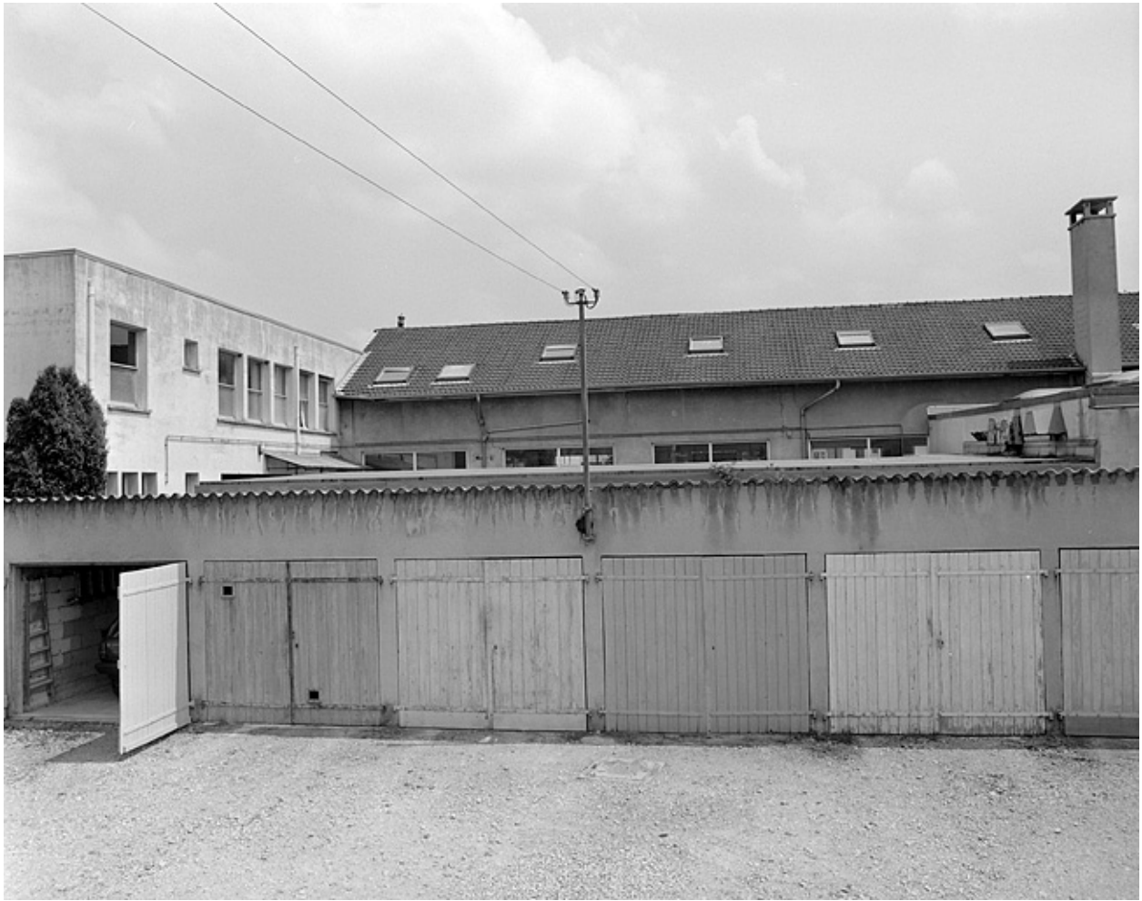
Bureau et atelier de fabrication depuis l'ouest.
