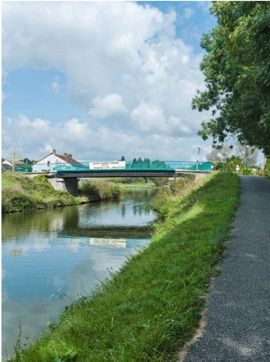
Vue d'ensemble du pont.
