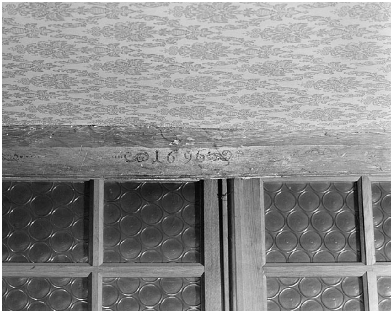
Premier corps de bâtiment. Plafond du rez-de-chaussée.
