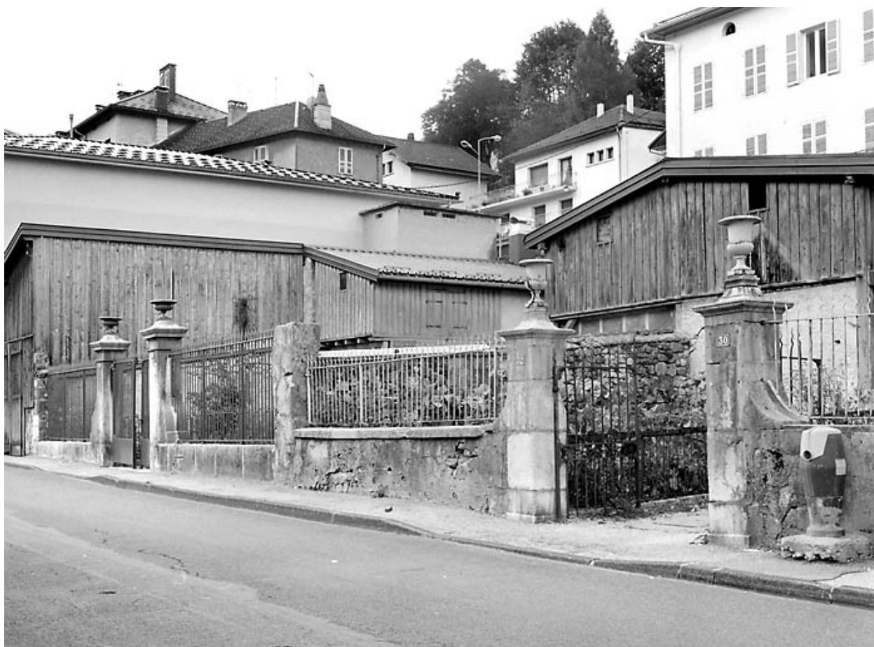
Clôture sur le quai Jobez.
