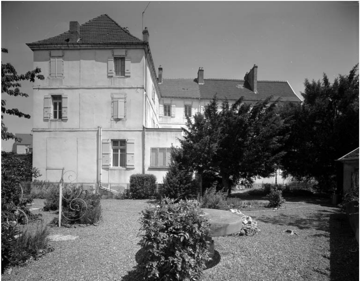
Façade postérieure du bâtiment principal : de face.
