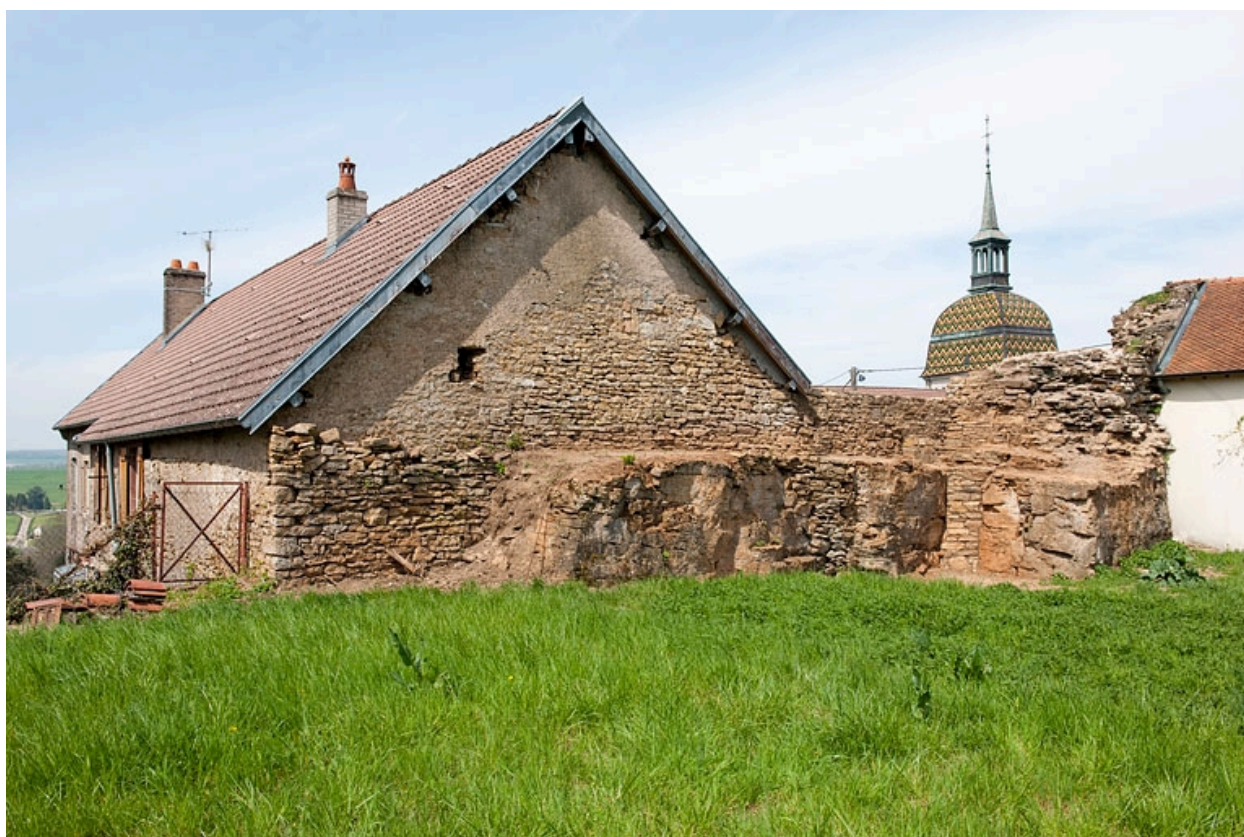
Vue du revers des vestiges d'une tour du château accolée à la "maison d'autrefois", Quartier de la Citadelle.
