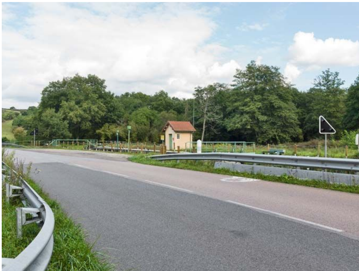
Vue d'ensemble du site d'écluse.
