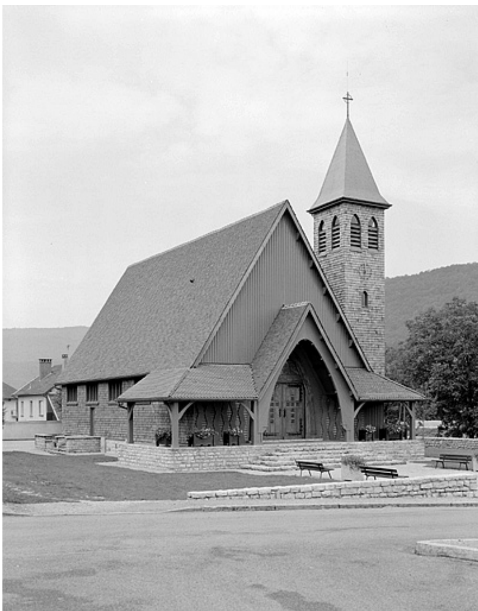
Façade ouest et face nord.
