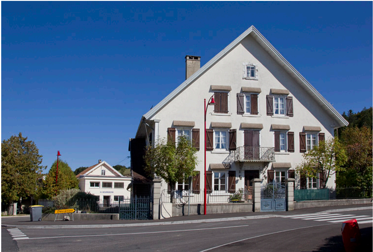
Vue d'ensemble depuis l'ouest.
